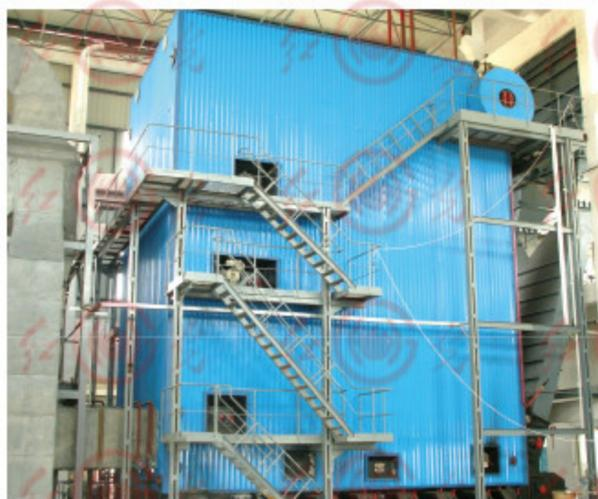
置, 保证了尾部省煤器及空气预热器不磨损不堵灰。锅炉原始烟气含尘浓度达标, 在额定工况下锅炉出口原始排放烟尘浓度  $\sim 1200\text{mg}/\text{m}^3$ 。有效地控制了污染物排放, 污染物各项指标远低于国家排放标准要求, 符合国家环境保护的要求。
