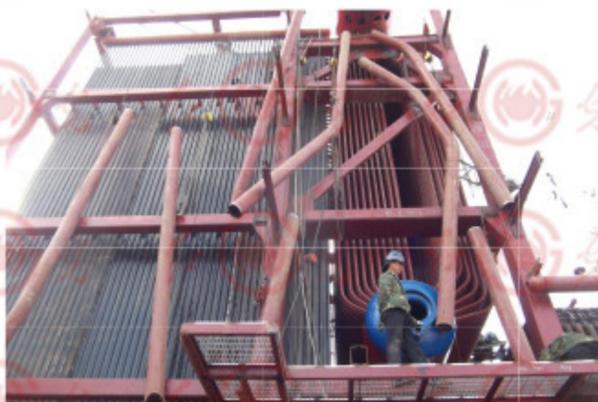
横向冲刷烟速均大于 $9\text{m/s}$ ，纵向冲刷 $\sim 18\text{m/s}$ ，即使在低负荷时，受热面不积灰，换热效率高。
