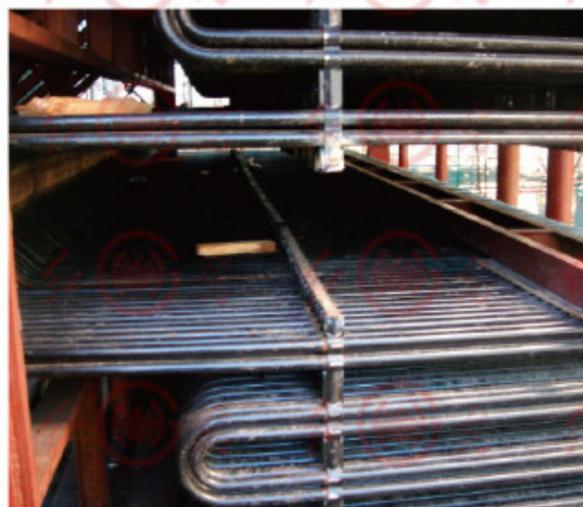
该锅炉给风系统是风经过空气预热器加热后进入锅炉。空气预热器按双行程两级布置，锅炉的检修和维护更换非常方便。为保证烟道的密封性能和管箱的自由膨胀，管箱上面四周装有胀缩接头。空气预热器出口热风温度为 $128^\circ\text{C}$ ，提高了燃烧效率。
