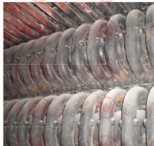
**5、尾部铸铁管式空气预热器受热面防腐蚀、防磨损，不积灰**
