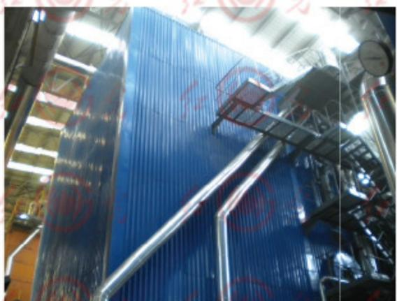
**9、锅炉具有水容量大，蓄热量大，温度调节方便，运行平稳，循环回路简单，升温升压快，具有一定的超负荷能力。**
