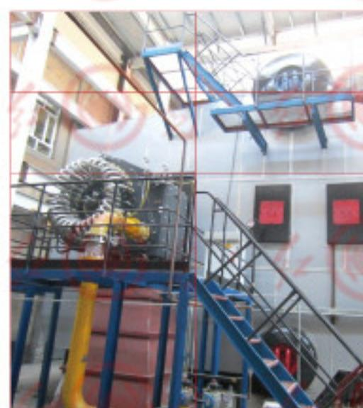
Szs 型燃油燃气水管锅炉
